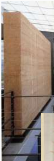
Mur de refend ou de séparation en pisé
