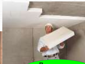
Panneaux par dessous
