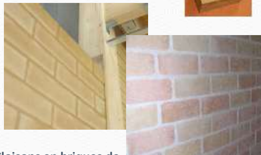
Cloisons en briques de terre crue comprimée (BTC)
