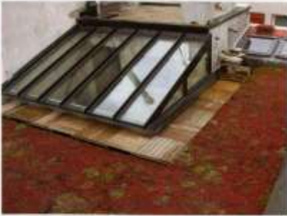
La végétalisation des toits dans les grandes villes (ici à Paris), en contribuant au renforcement des espaces verts, permet de réduire l'effet d'îlot thermique urbain. © Soprema.
